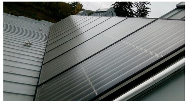
Abbildung 17: Röhren und CPC Kollektoren
