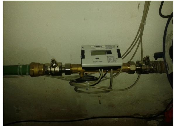
Abb. 2 Warmwasser-Wärmemengenzähler
