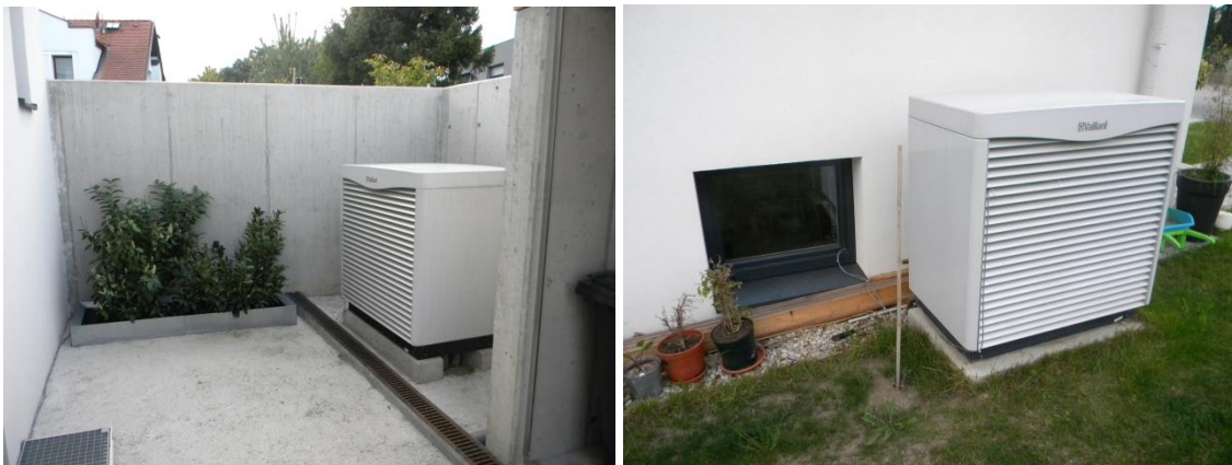
Abbildung 11: Suboptimaler Aufstellungsort (links), guter Aufstellungsort (rechts) für Außeneinheit
