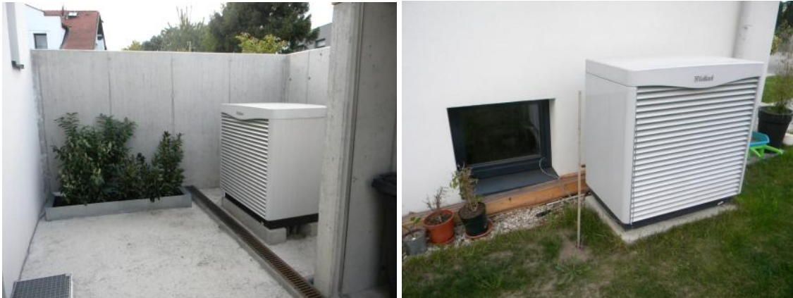
Abbildung 78: Suboptimaler Aufstellungsort (links), guter Aufstellungsort (rechts) für Außeneinheit
