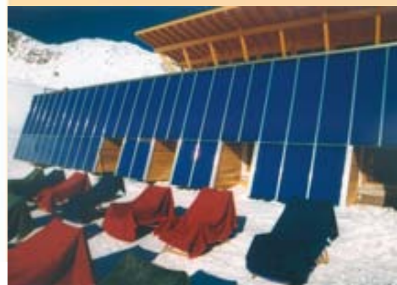
Bildquelle: TiSun / Arch. Mathoy Skirestaurant Masner, Serfaus: Nutzung von Solarenergie für Warmwasserbereitung und Raumheizung
