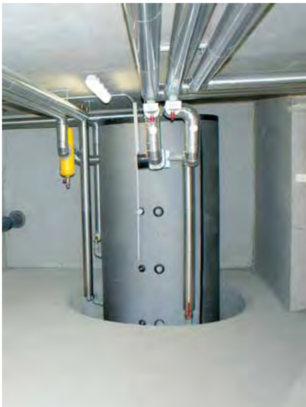
◀ Fundamentabsenkung und Speichereinbringung vor dem Versetzen der Kellerdecke sind Standard im Neubau.
