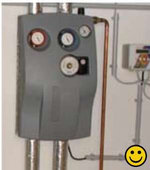
Sicherheitstechnik, Abblaseleitung
