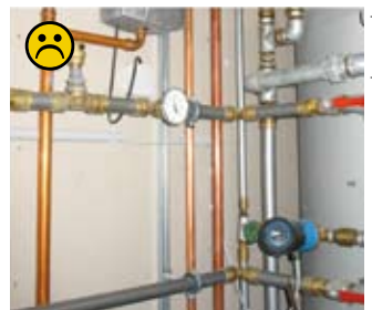
Beispiel für unzureichend gedämmte Rohrleitung
