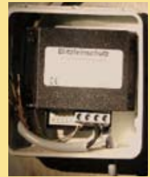
Überspannungsschutz
