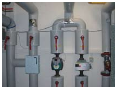
Gedämmte Armaturen
