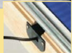
Befestigung der Fühlerleitung
