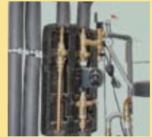
Isolierung von Armaturen und Pumpen
