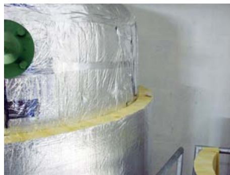
Ein gut gedämmter Pufferspeicher erhöht wesentlich die Effizienz der Heizungsanlage
