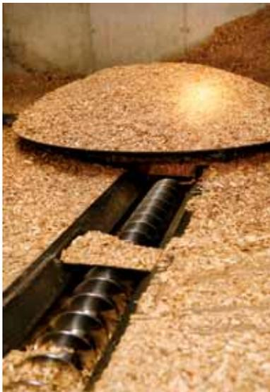
Mittels einer Förderschnecke werden die Hackschnitzel aus dem Lagerraum zum Kessel transportiert
