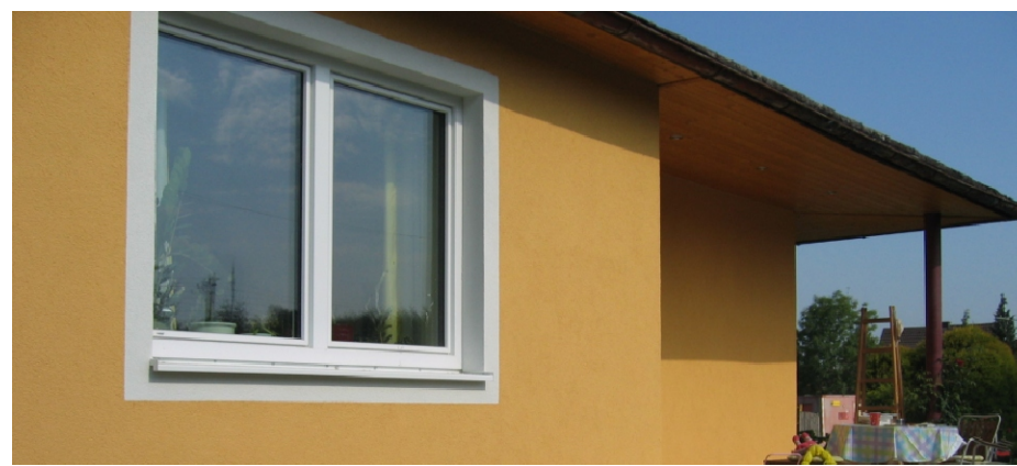
Nach Sanierung | Foto: Franz Gugerell
