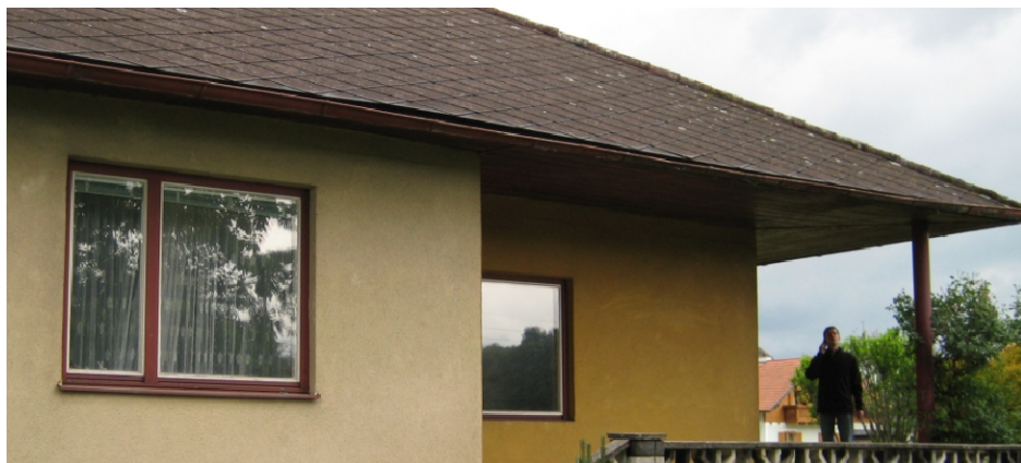
Vor Sanierung | Foto: Franz Gugerell
