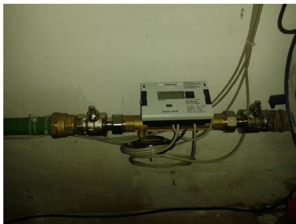
Abb. 2 Warmwasser-Wärmemengenzähler
