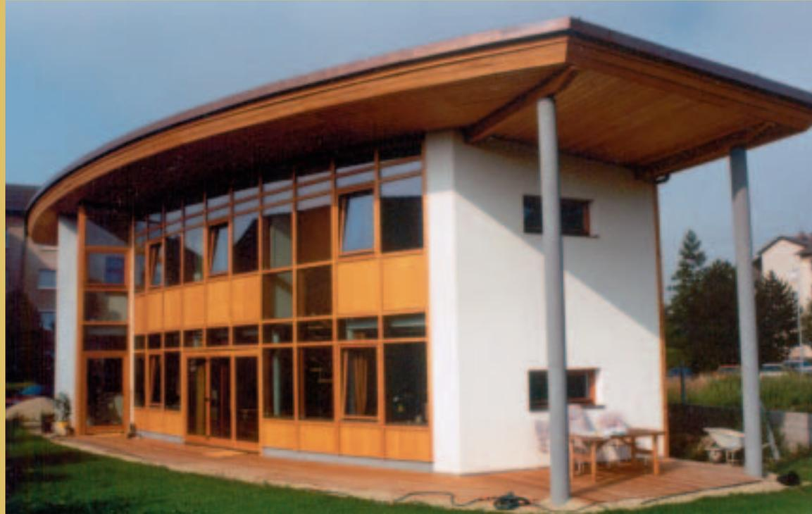
*Dieses „Generationenhaus“ mit 3 Wohneinheiten wurde als Niedrigstenergiehaus mit der Wohnqualität eines Passivhauses ausgeführt. Ausgestattet wurde das Gebäude mit Pelletsheizung, Wandheizsystem, Solaranlage und automatischer Wohnraumkomfortlüftung mit Erdreichwärmetauscher, gebaut wurde mit überwiegend ökologischen Baustoffen.*
