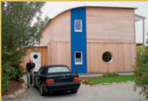
Niedrigstenergiehaus in NÖ, kompakte Bauweise und großzügige Öffnung der Südfassade
