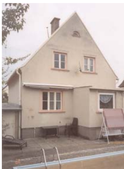
Ansicht Hausrückseite mit Windfang
