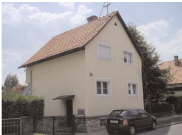
Ursprüngliches Wohnhaus vor der Sanierung
