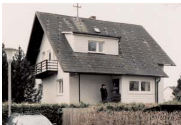
Ursprüngliches Wohnhaus vor der Sanierung
