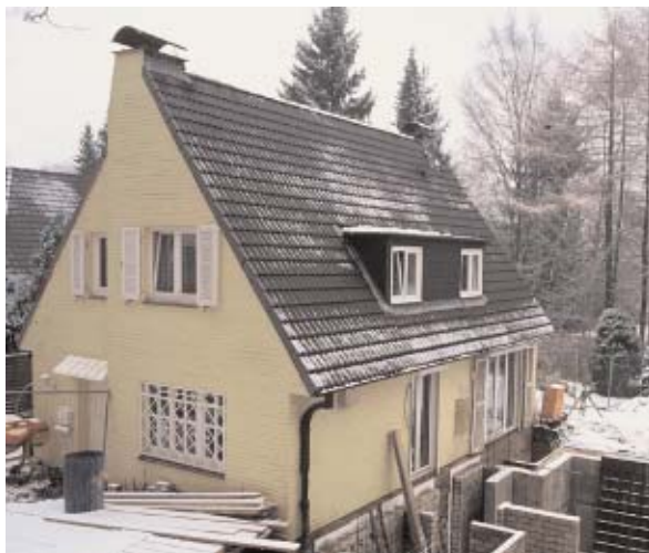
Ursprüngliches Wohnhaus vor der Sanierung
