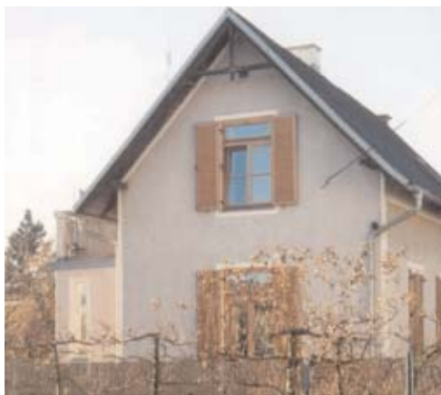
Ursprüngliches Wohnhaus vor der Sanierung
