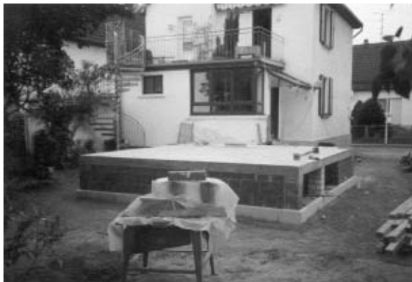
Ursprüngliches Wohnhaus vor der Sanierung
