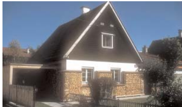
Wohnhaus vor der Sanierung
