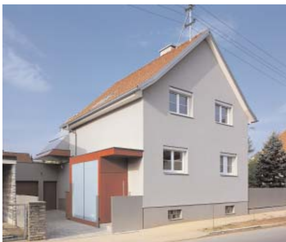
Strassenseitige Ansicht nach der Sanierung
