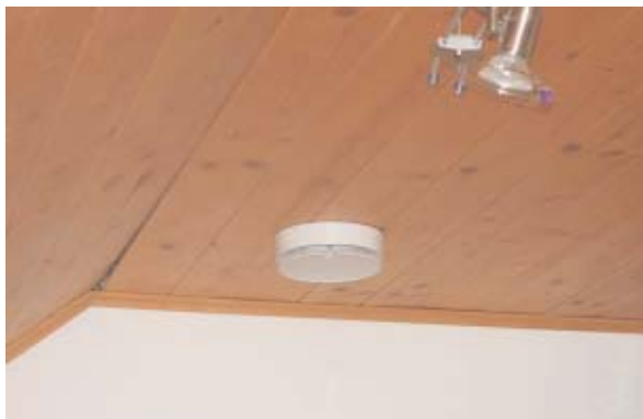
Zuluftöffnung mit Weitwurf Funktion in einem sanierten Altbau
