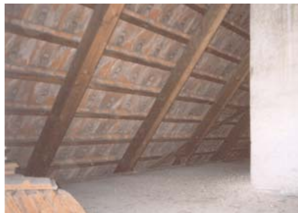
Oberste ungedämmte Geschoßdecke und Dach
