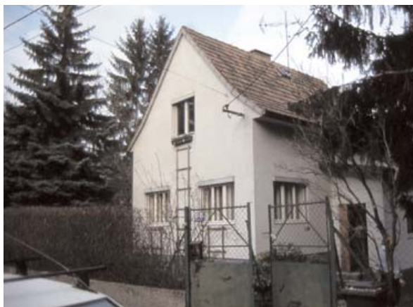
Wohnhaus vor der Sanierung
