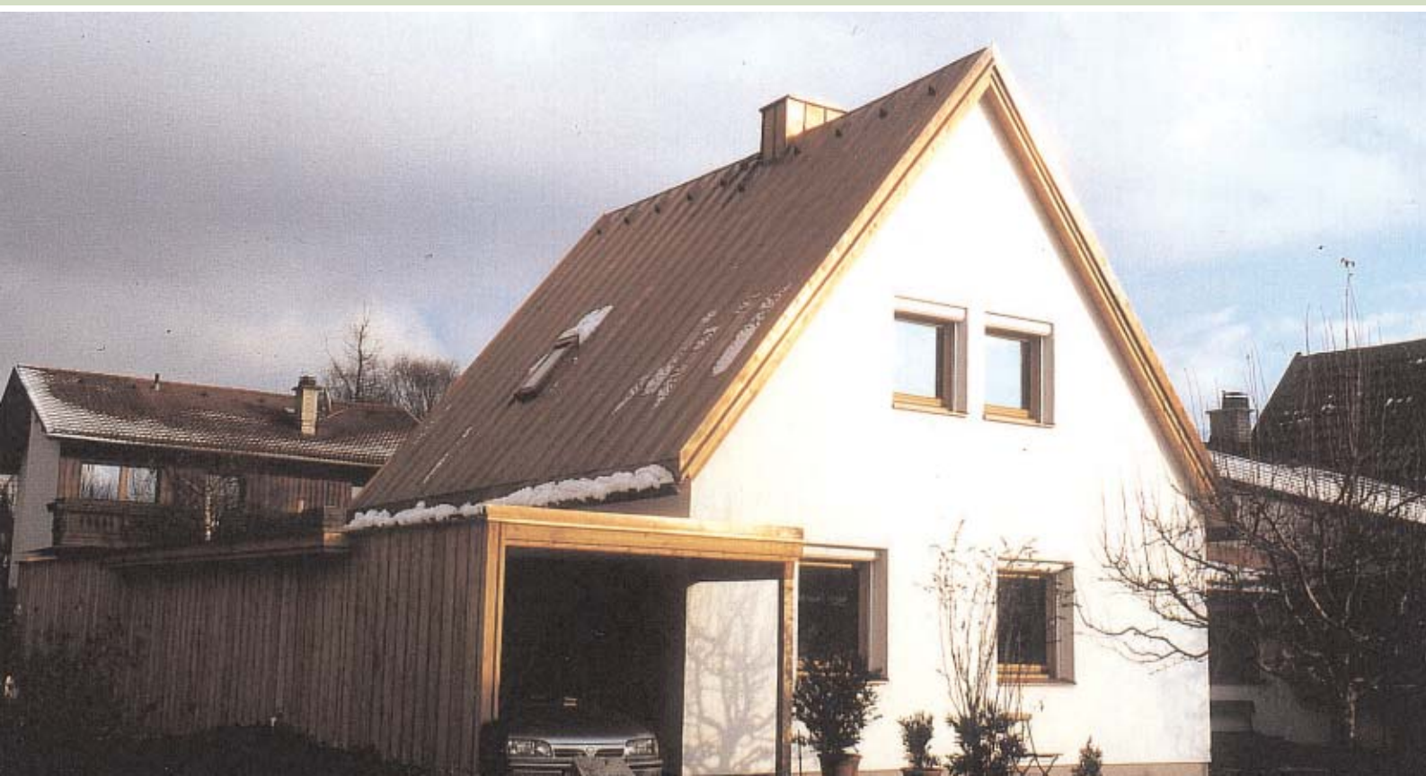
Projekt Wehinger: Siedlungshaus nach der Sanierung
