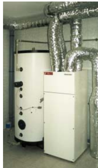
Wärmepumpenkompaktaggregat für Passivhäuser. Die gesamte Haustechnik für Heizung, Warmwasser und Lüftung ist in einem Kompaktgerät von Gefrierschrankgröße integriert
