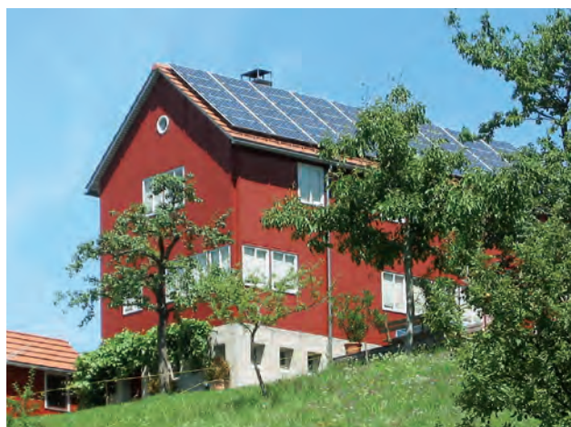
Zusammenhängende, rechteckige Fläche. Symmetrisch zur bestehenden Dachfläche.
