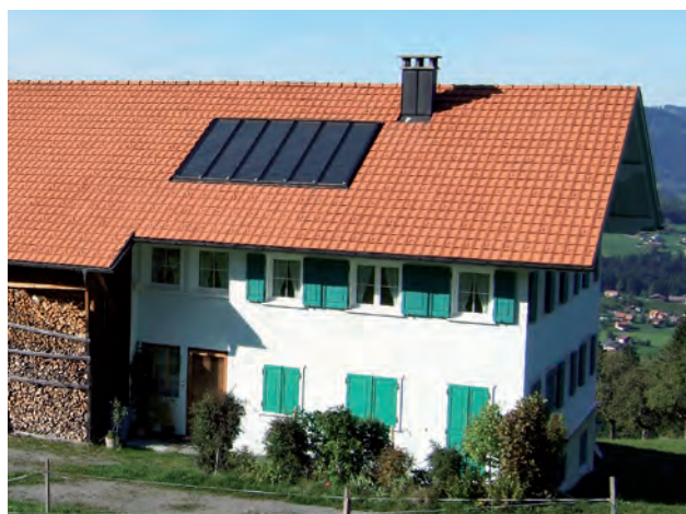
Thermischer Kollektor in die Dachhaut integriert. Optisch ansprechend, dabei mit deutlich geringeren Wärmeverlusten.
