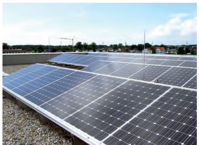
Kollektorfelder bleiben unterhalb der Attika und sind vom Strassen- und Freiraum nicht einsehbar.
