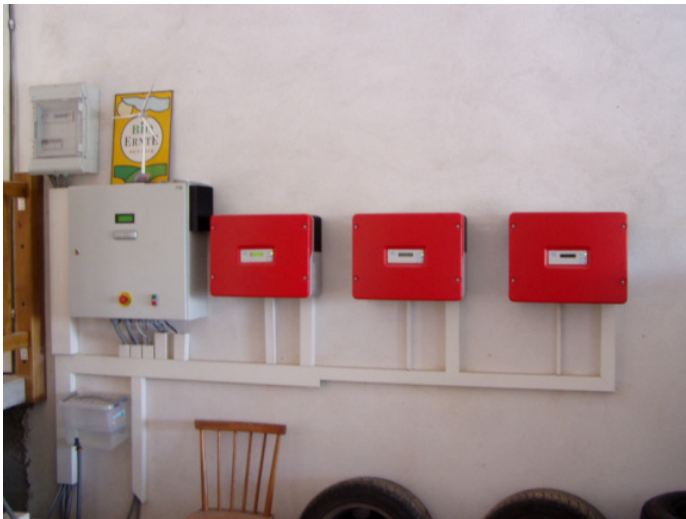
Abbildung 13:3 Wechselrichter(rot) und Steuergerät (links)
