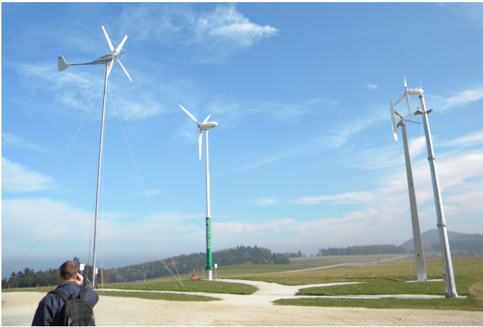
Abbildung 24: Vlnr: Stahlrohrmast abgespannt, Stahlrohrmast klappbar, Betonmast, Stahlrohrmast in Segmenten
